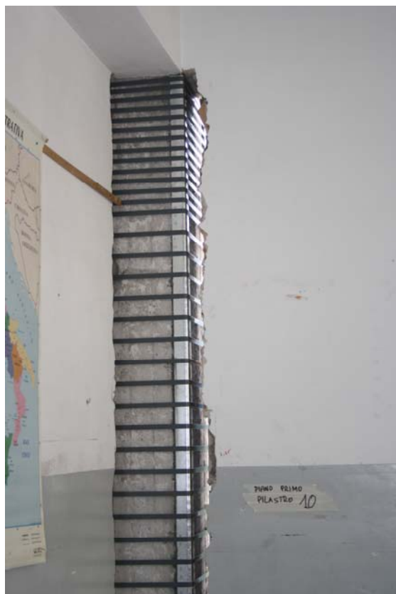
Figura 1 e 2: Foto dell'intervento. Si noti la scarsa invasività dell'intervento. Si è proceduto esclusivamente alla demolizione di una piccola porzione di tramezzi e pilastri in corrispondenza dei pilastri salvaguardando gli infissi, imbotti e gli impianti. I tempi di esecuzione sono stati inoltre
