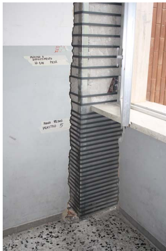
Figura 1 e 2: Foto dell'intervento. Si noti la scarsa invasività dell'intervento. Si è proceduto esclusivamente alla demolizione di una piccola porzione di tramezzi e pilastri in corrispondenza dei pilastri salvaguardando gli infissi, imbotti e gli impianti. I tempi di esecuzione sono stati inoltre
