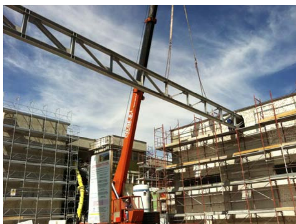
Figura 2: Rinforzo copertura palestra con inserimento travi reticolari in acciaio
